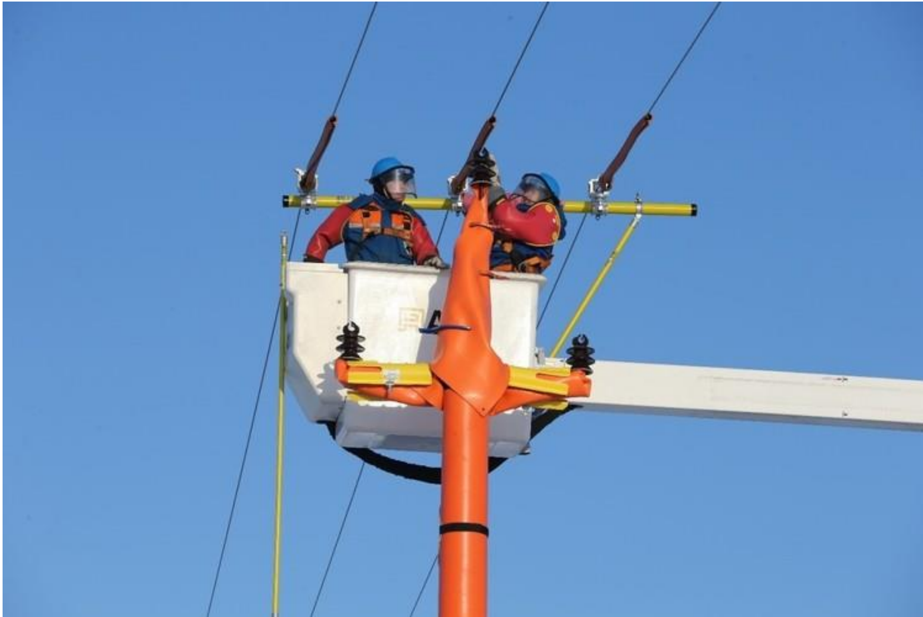
Замена опор ВЛ.
